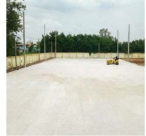
4. ปรับพื้นด้วยหินเกล็ด 3/8 บดอัดชั้นพื้นหินให้แน่นและได้ระดับ
