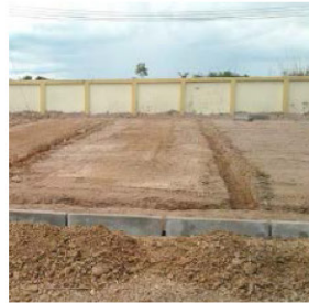
2. ติดตั้งขอบคั่นหิน พร้อมขุดแนวท่อระบายน้ำ
