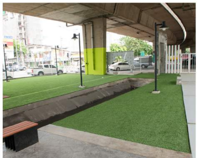
สวนสาธารณะ ใต้ทางยกระดับ
